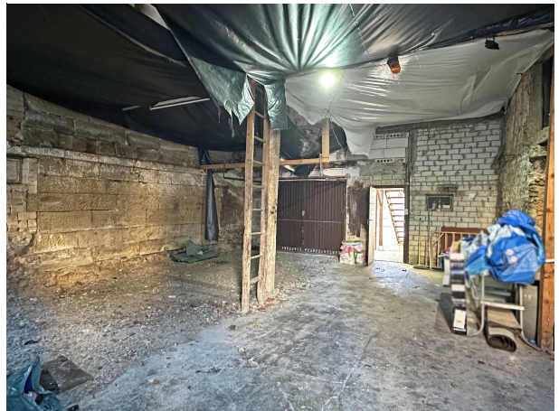
Scheune Richtung Hofeinfahrt
