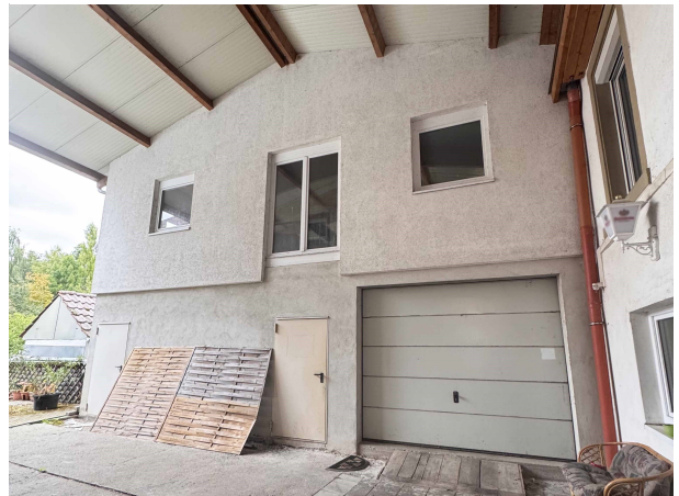
Zugang zur Gebäude 5
