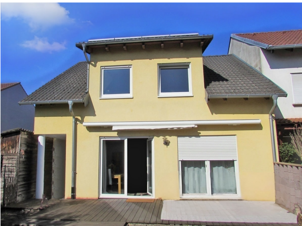
Blick auf das Hinterhaus
