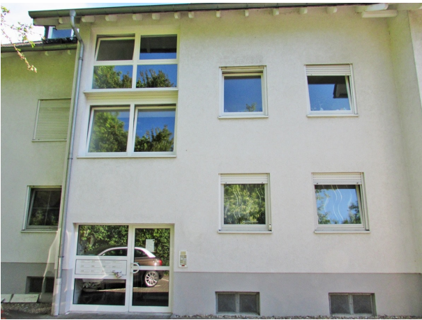
Eingangsbereich des Hauses
