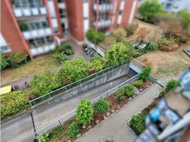
Blick auf die Tiefgarageneinfahrt
