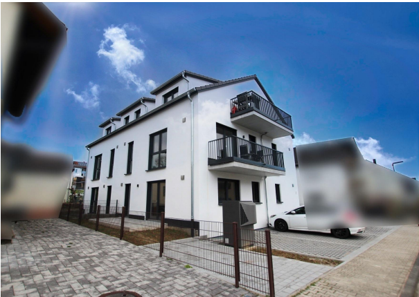
Straßenansicht von links
