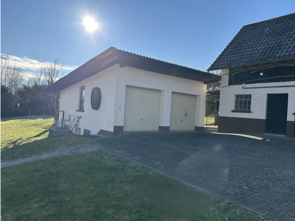
Doppelgarage und Nebengebäude
