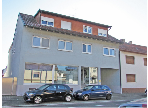
Blick auf das Gebäude
