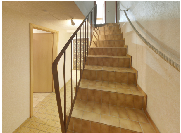
Treppe ins UG
